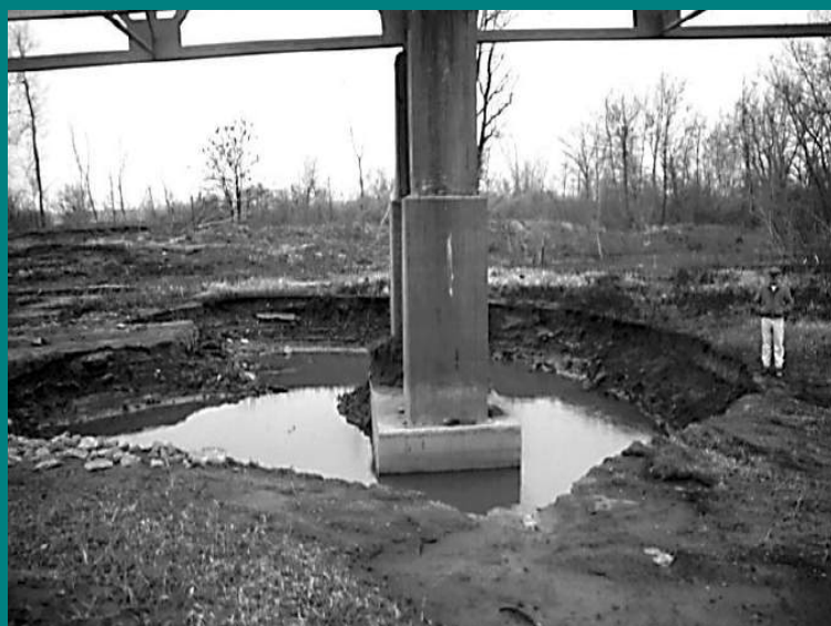
شواهد آبشستگی سطحی اطراف پایه پل
